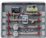
Termoregolazione ambiente e del fluido termovettore a doppia sezione diretta e miscelata. Sistema di abbattimento della temperatura per impianti a pavimento in versione a punto fisso termostatico o regolazione climatica.
